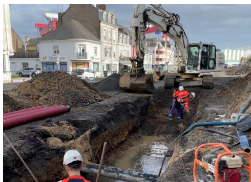
Le chantier de réfection de la voirie lourde prendra fin en mars.
