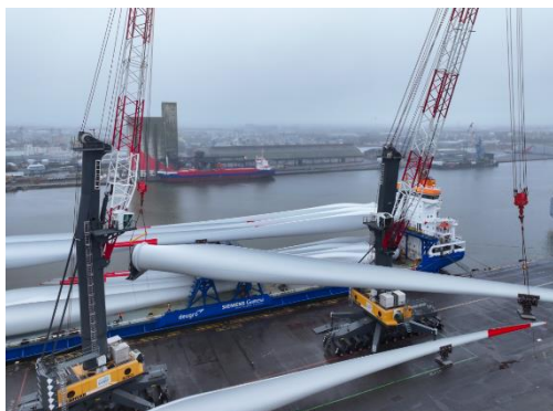
Les composants d'éoliennes arrivent à Saint-Nazaire par voie maritime depuis fin octobre.
