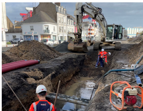
Las grandes obras de la calzada finalizarán en marzo.
