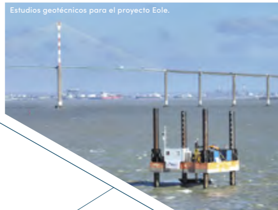
Estudios geotécnicos para el proyecto Eole.
