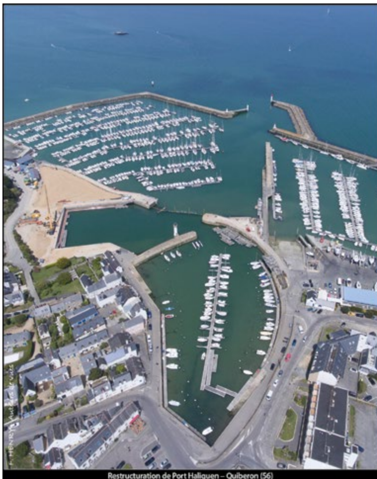
Restructuration de Port Haliguen – Quiberon (56)
